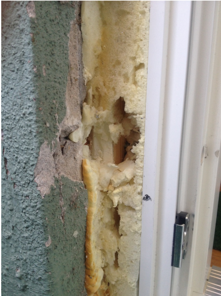
Drevning går ända ut till yttre plåtbeslag, avsaknad av yttre luftkanal
