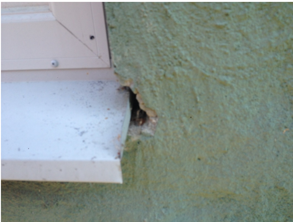
Vanligt förekommande glipor i samband med anslutning av fönsterbleck
