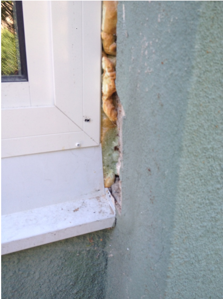
Drev blockerar en ev. luftkanal runt fönstret
