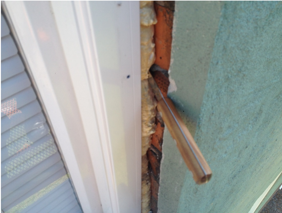
Håligheter mellan drev och befintlig vägg, otillfredsställande drevning
