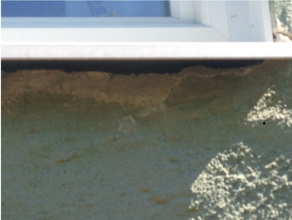
Lagning under fönster, dålig vidhäftning mot befintlig puts
