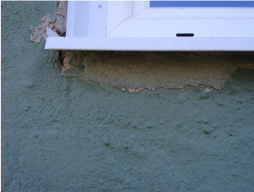
Lagning sprucken mot befintlig puts
