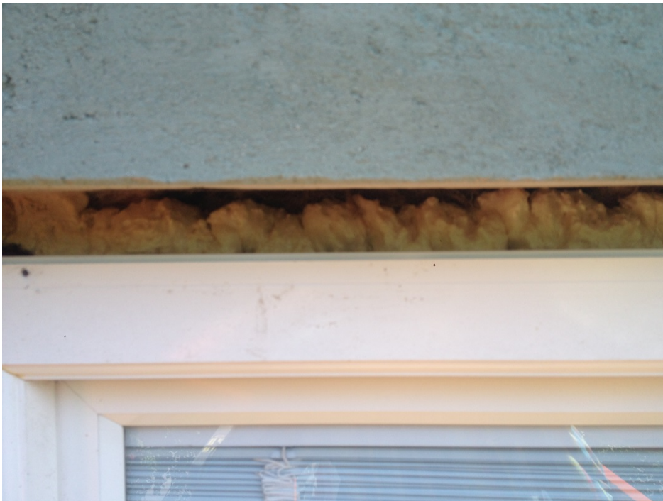
Otillfredsställande drevning ovan fönster
