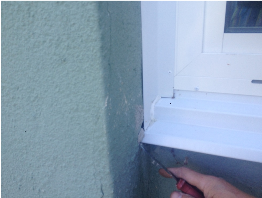
Sprickor i puts
