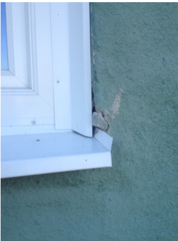
Hörn fönsterbleck plåtbeklädnad, sprucket.
