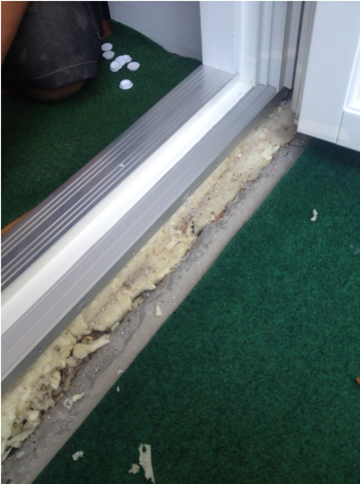
Balkongdörr, hålkål bortstaget vid tröskel av fönsterdörr
